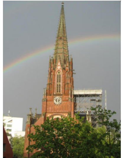
Foto: S. Sonnenburg Turm der Christuskirche mit Außengerüst
